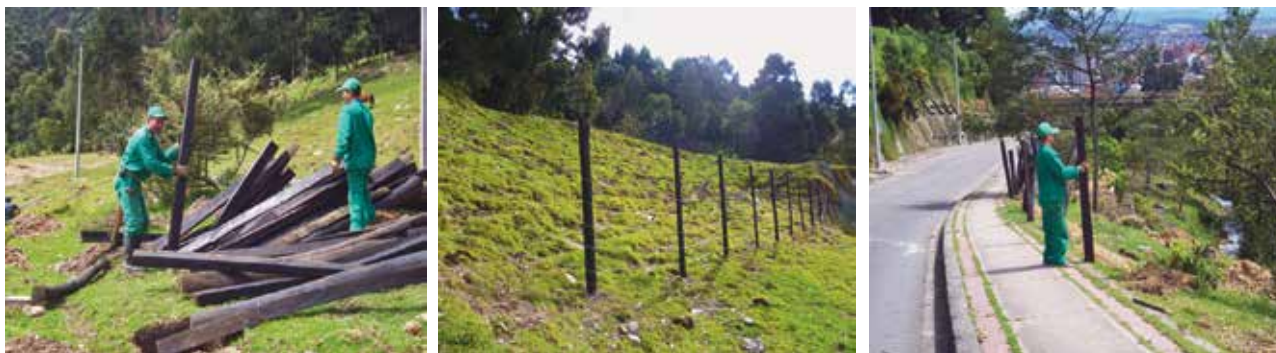
Figura 3.17. Instalación del cerramiento en alambre de púa a lo largo de un perímetro de 350 m
