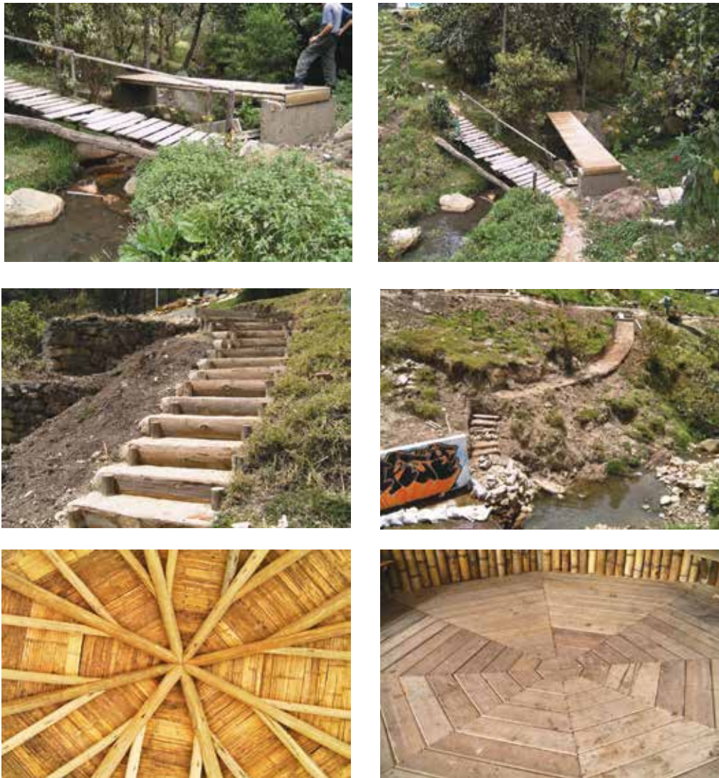
Figura 3.22 Fotografías del proceso constructivo en el sector 3 de la quebrada las Delicias
