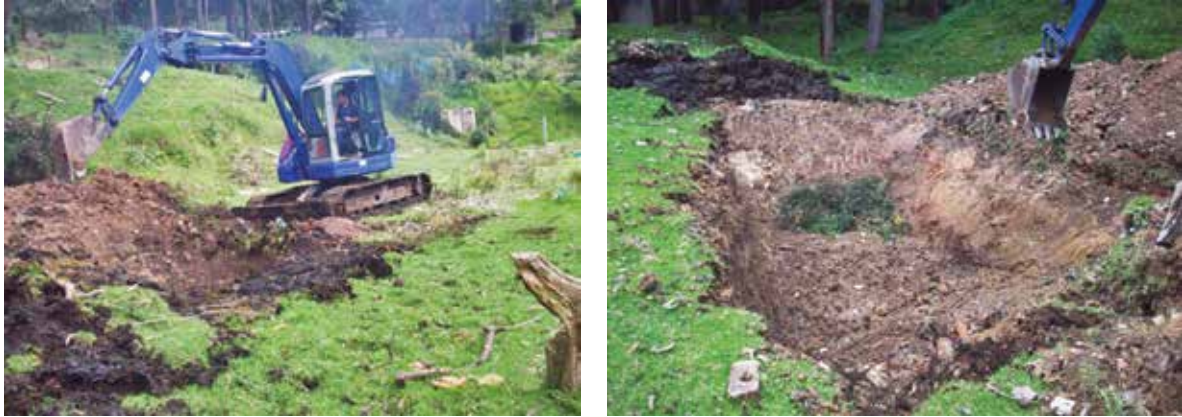
Figura 3.8 Lugar de depósito de retamo. Hueco con capacidad de almacenamiento de 250 m3 de retamo.
