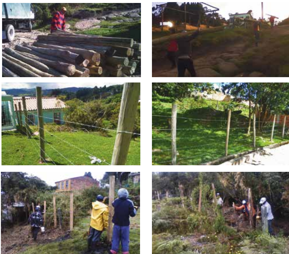
Figura 3.24 Instalación de la cerca de protección de las áreas a restaurar
