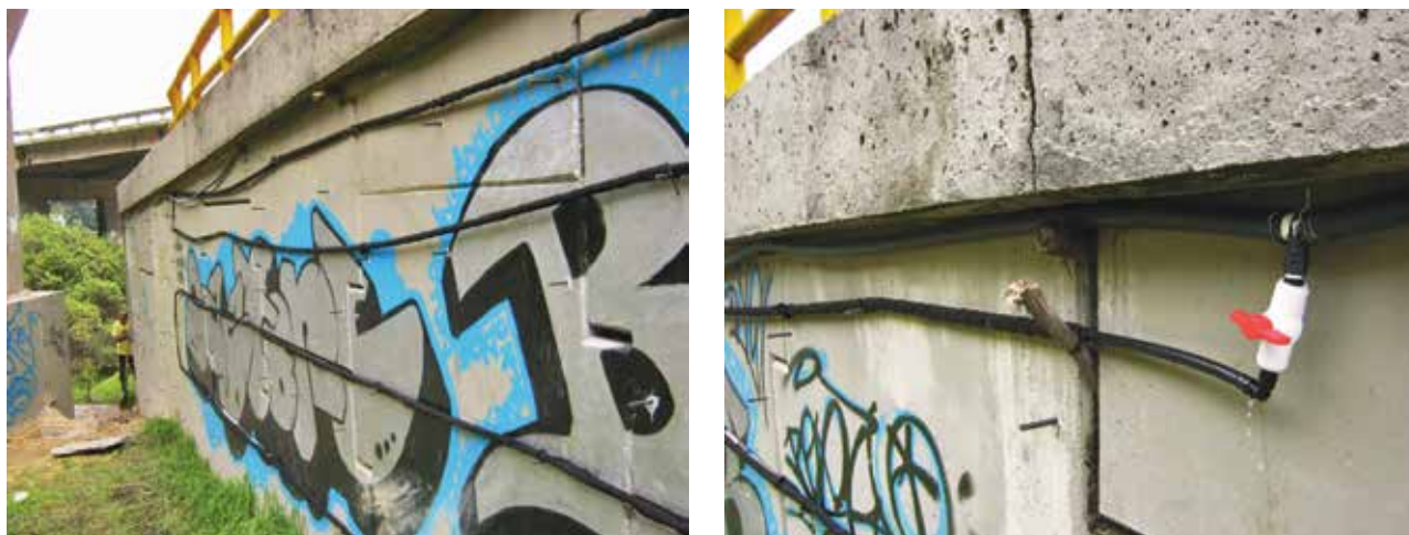
Figura 3.20a. Instalación sistema de riego — manguera recubierta en geotextil.
