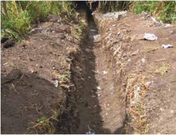
Figura 3.27 Proceso de saneamiento realizado en la quebrada Morací.
